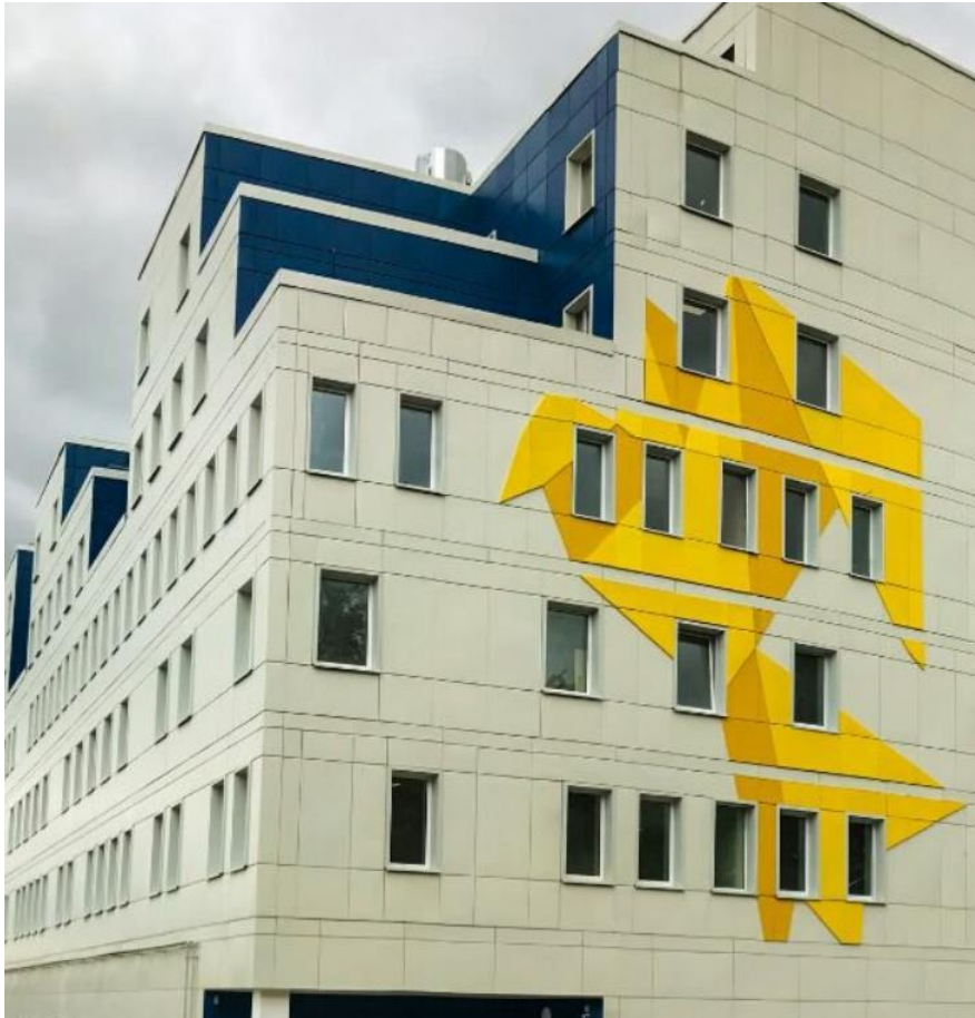
г. Коломна, ул. Дзержинского Перинатальный Центр
